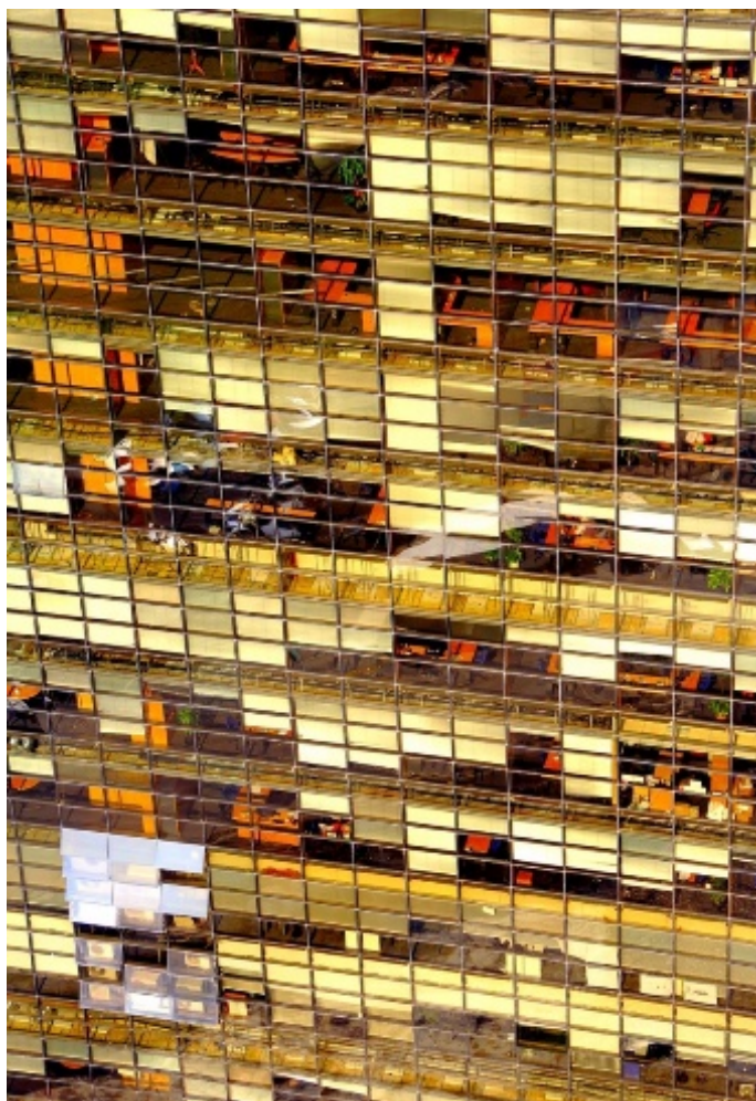
Imagen 1. Fachada original edificio Carlos Pellegrini-UIA, 2013
