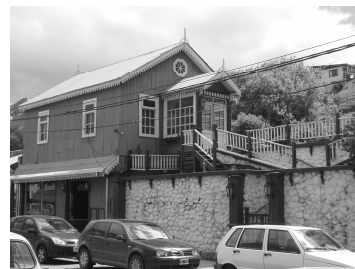
Fig.19 y 20 : Uso de chapa como cerramiento vertical y bow-window como forma vernácula de captación solar en climas fríos extremos.
