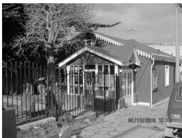
Fig.19 y 20 : Uso de chapa como cerramiento vertical y bow-window como forma vernácula de captación solar en climas fríos extremos.
